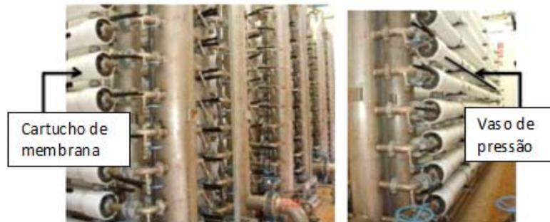
Fig. 2- Detalhe da planta de Ultrafiltração.
