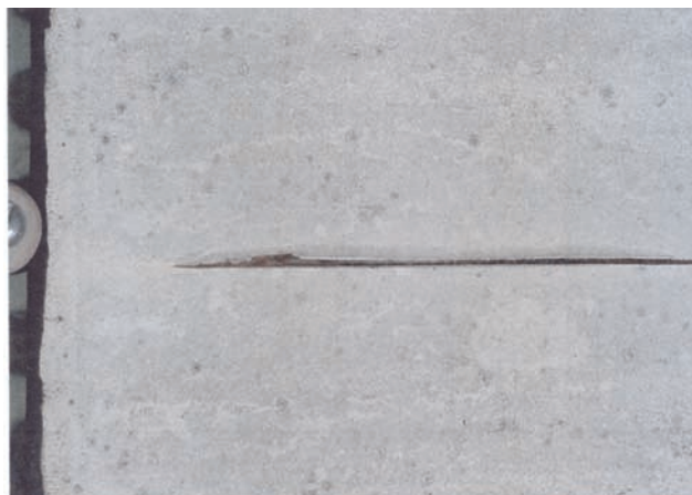
Fig. 4 – Esquema con pintura de fondo etil silicato, actuando por protección catódica, y acabado acrílico mostrando la presentación de hongos, en la ciudad de Santa Cruz.
